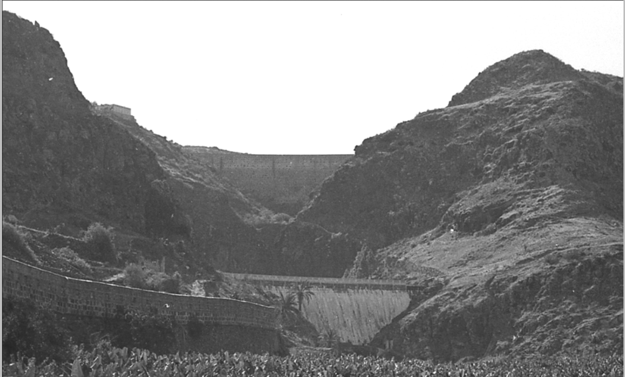
En lo alto la Presa del Capitán o de Cardoso, debajo la Presa del Conde construidas en el Barranquillo del Conde o Cardoso a mediados del siglo XX. Foto de Paco Rivero años 70 siglo XX (Archivo Fundación Canaria Néstor Álamo)
