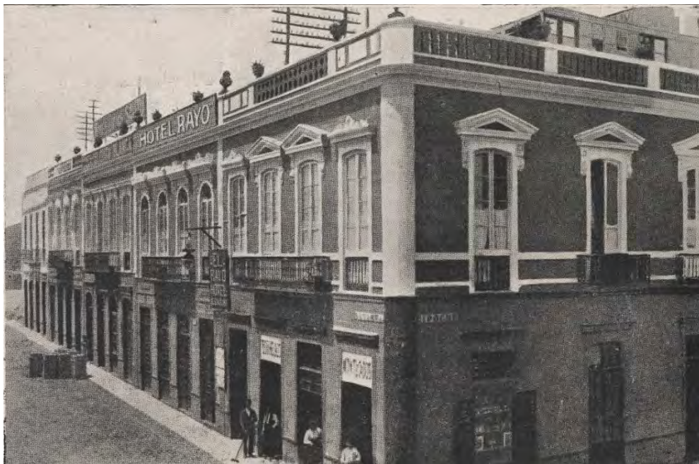
Foto de las viviendas en torno a 1927-1930 (FEDAC). Como se aprecia en la fotografía los bajos están ocupados por comercios y uno de los edificios por el Hotel Rayo.
