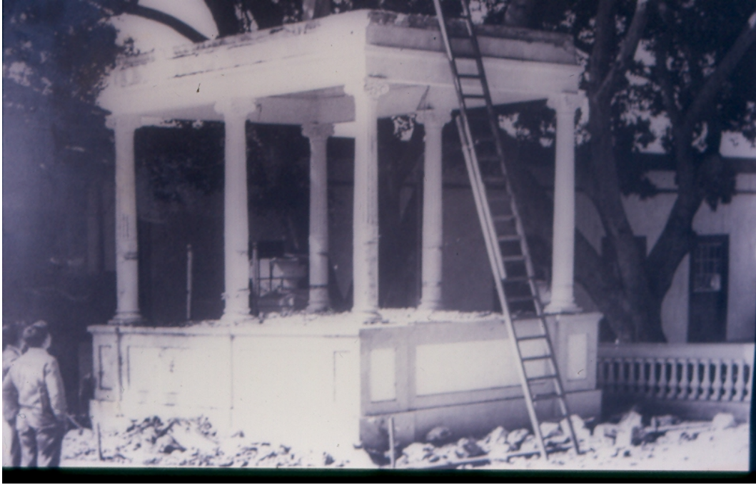
▲ Demolición del Kiosco de la música 1960-61.
